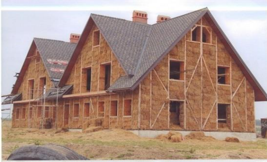
Şekil 3. Saman balyasından yapılmış bir ev (Caldwell, 2016)
